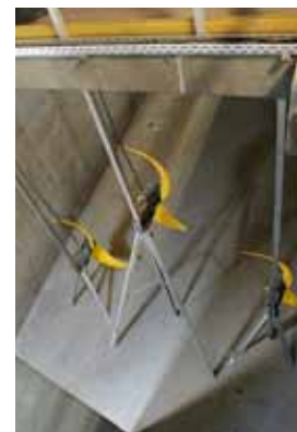
Johdeputkijärjestelmän ansiosta sekoittimiin pääsee helposti käsiksi.
