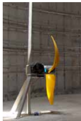
Johdeputkijärjestelmän ansiosta sekoittimiin pääsee helposti käsiksi.
